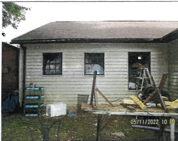
EXTERIOR SIDE B-2
