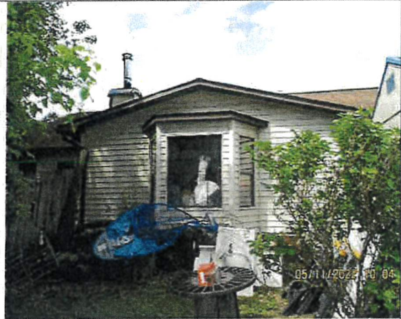
EXTERIOR SIDE B-1
